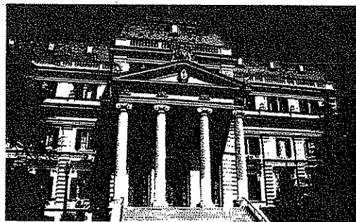
Legislatura de la Provincia de Buenos Aires, en la ciudad de La Plata.
